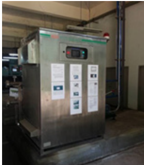
เครื่องไอโซนที่นำไปติดตั้งและไดอะแกรมการติดตั้งระบบไอโซน
