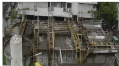
รูปส่วนประกอบของระบบบำบัดน้ำเสียแบบตะกอนเร่ง
