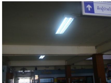
รูปแสดงมาตรการเปลี่ยนหลอดฟลูออเรสเซนต์ ขนาด 36 วัตต์ เป็นหลอดประหยัดไฟ LED
