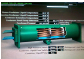
รูปที่ Chiller No.5 Condenser Approach temperature = 1.3 F
