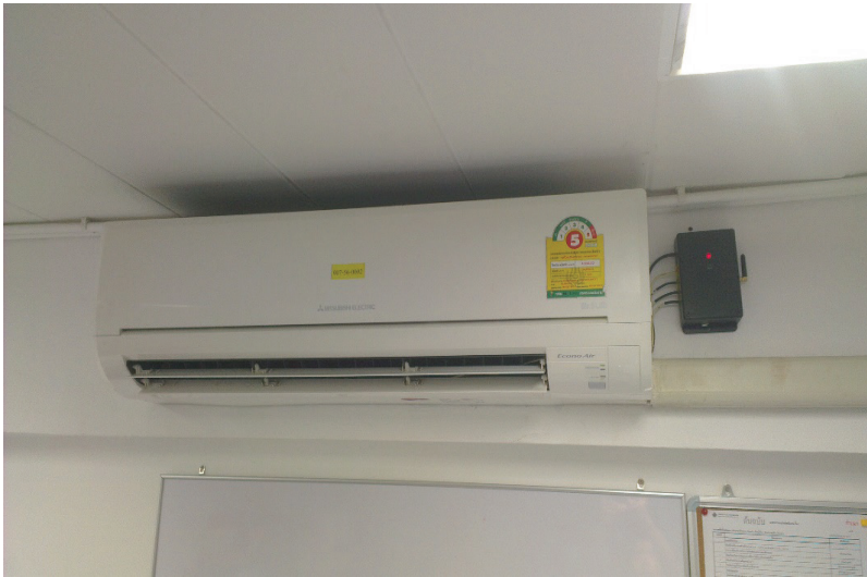
รูปที่ 3.63 แสดงเครื่องปรับอากาศที่ติดตั้งชุดตรวจสอบประสิทธิภาพแบบ Realtime Air Conditioning Performance Indicator (ACPI)
