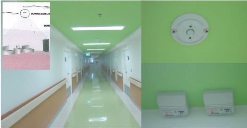
รูปที่ 3.36 แสดงการติดตั้งอุปกรณ์ควบคุมกำลังไฟสำหรับแสงสว่าง โดยไมโครโปรเซสเซอร์
