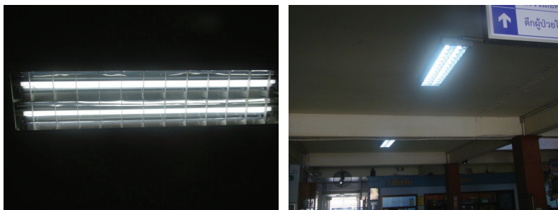
รูปที่ 3.35 แสดงมาตรการเปลี่ยนหลอดฟลูออเรสเซนต์ขนาด 36 วัตต์ เป็นหลอดประหยัดไฟ LED
