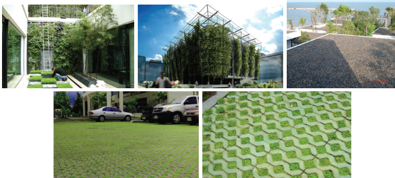
รูปที่ 2.11 แสดงการป้องกันการสะท้อนจากผิวดินเข้าสู่ตัวอาคาร
