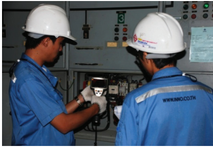
รูปที่ 3.64 แสดงการตรวจสอบอุปกรณ์ในตู้ไฟฟ้า รูปที่ 3.65 แสดงผลภาพถ่ายทางความร้อน
