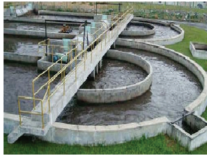
รูปที่ 3.38 แสดงส่วนประกอบของระบบบำบัดน้ำเสียแบบคลองวนเวียน
