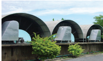
รูปที่ 3.37 แสดงส่วนประกอบของระบบบำบัดน้ำเสียแบบ RBC
