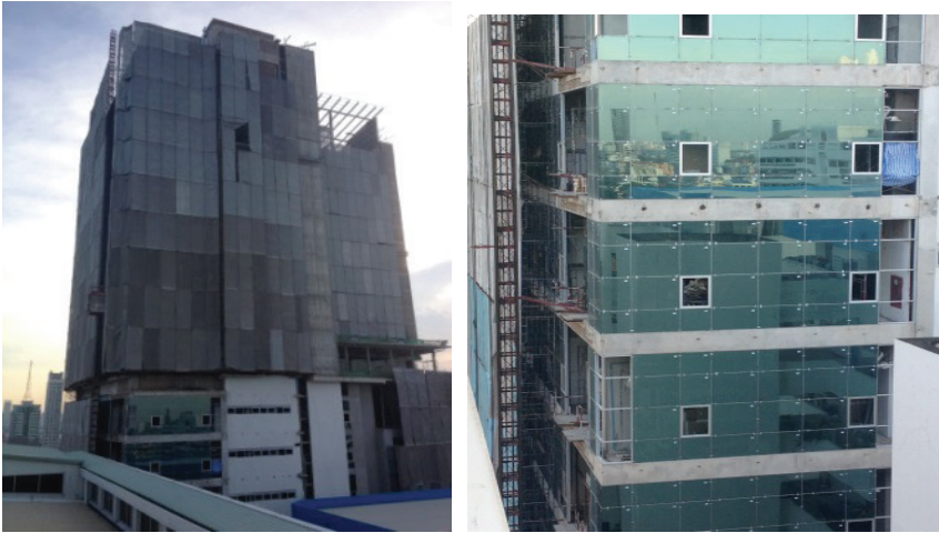
การปรับปรุงเปลือกอาคารโดยใช้กระจก Double Low E
