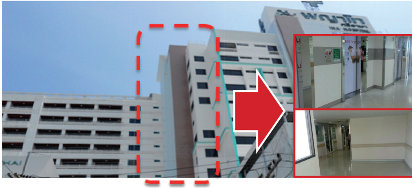
รูปที่ 2.13 ทางเชื่อมระหว่างอาคาร A และ อาคาร B
