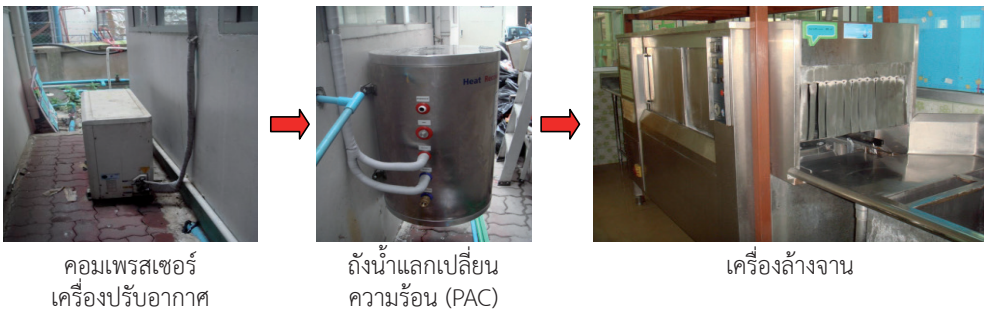
รูปที่ 3.54 การติดตั้งระบบผลิตน้ำร้อนจากเครื่องปรับอากาศแบบแยกส่วน
