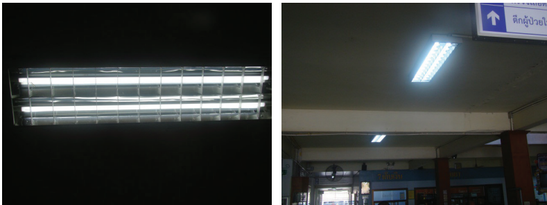
รูปที่ 3.35 แสดงมาตรการเปลี่ยนหลอดฟลูออโรเรสเซนต์ขนาด 36 วัตต์ เป็นหลอดประหยัดไฟ LED
